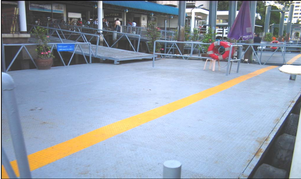
รูปภาพแสดงพื้นโปะต้องเป็นพื้นที่เรียบ ไม่ลื่น และต้องไม่มีสิ่งกีดขวางใดๆ
