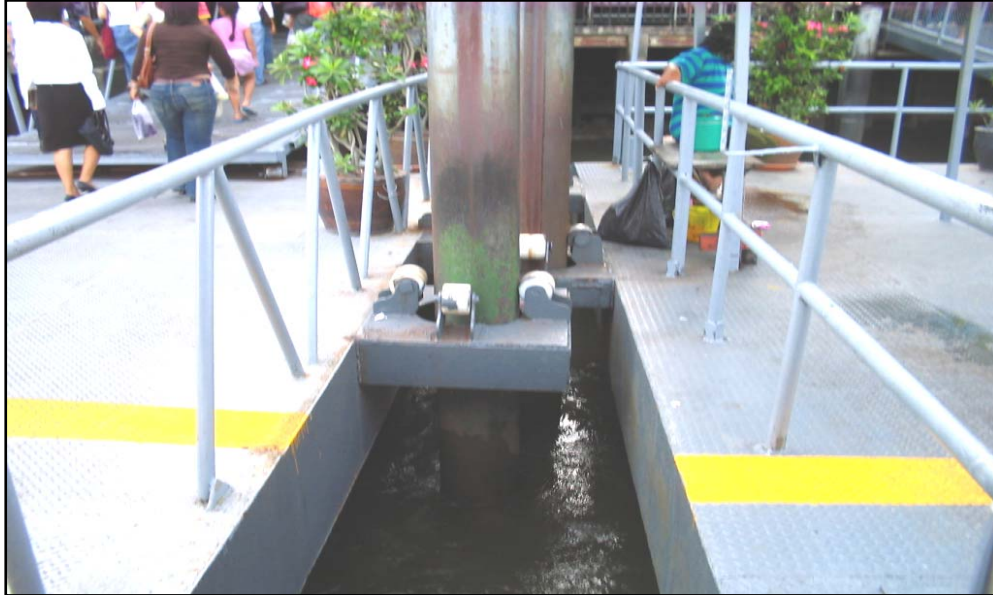
รูปภาพแสดงท่าเทียบเรือแบบลอยตัว (โป๊ะ) ที่นำมาใช้เพื่อให้มีการเปลี่ยนระดับตามระดับน้ำ
